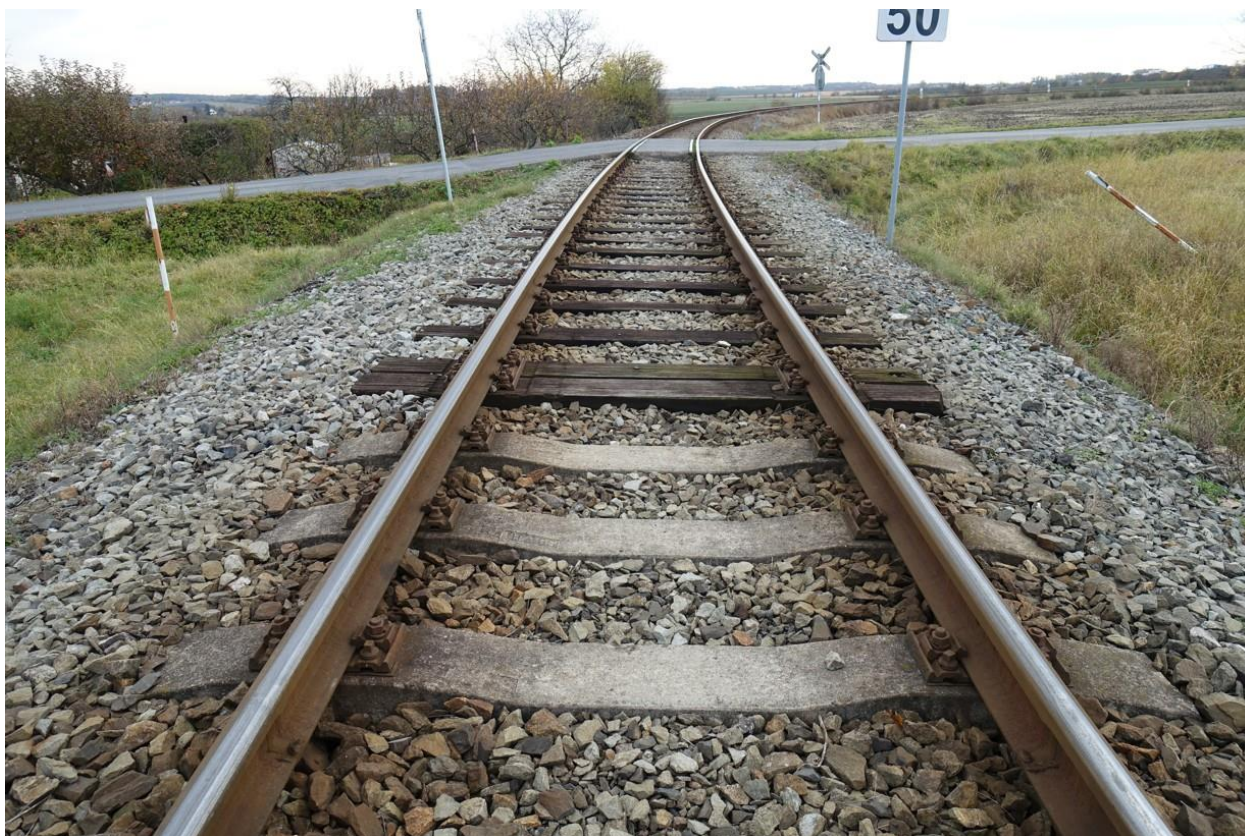
Foto 3 – Pohled na přejezd P2553 s převýšením opačného smyslu oproti niveletě komunikace – vlevo koleje je výrazný nenormový zlom v niveletě komunikace
