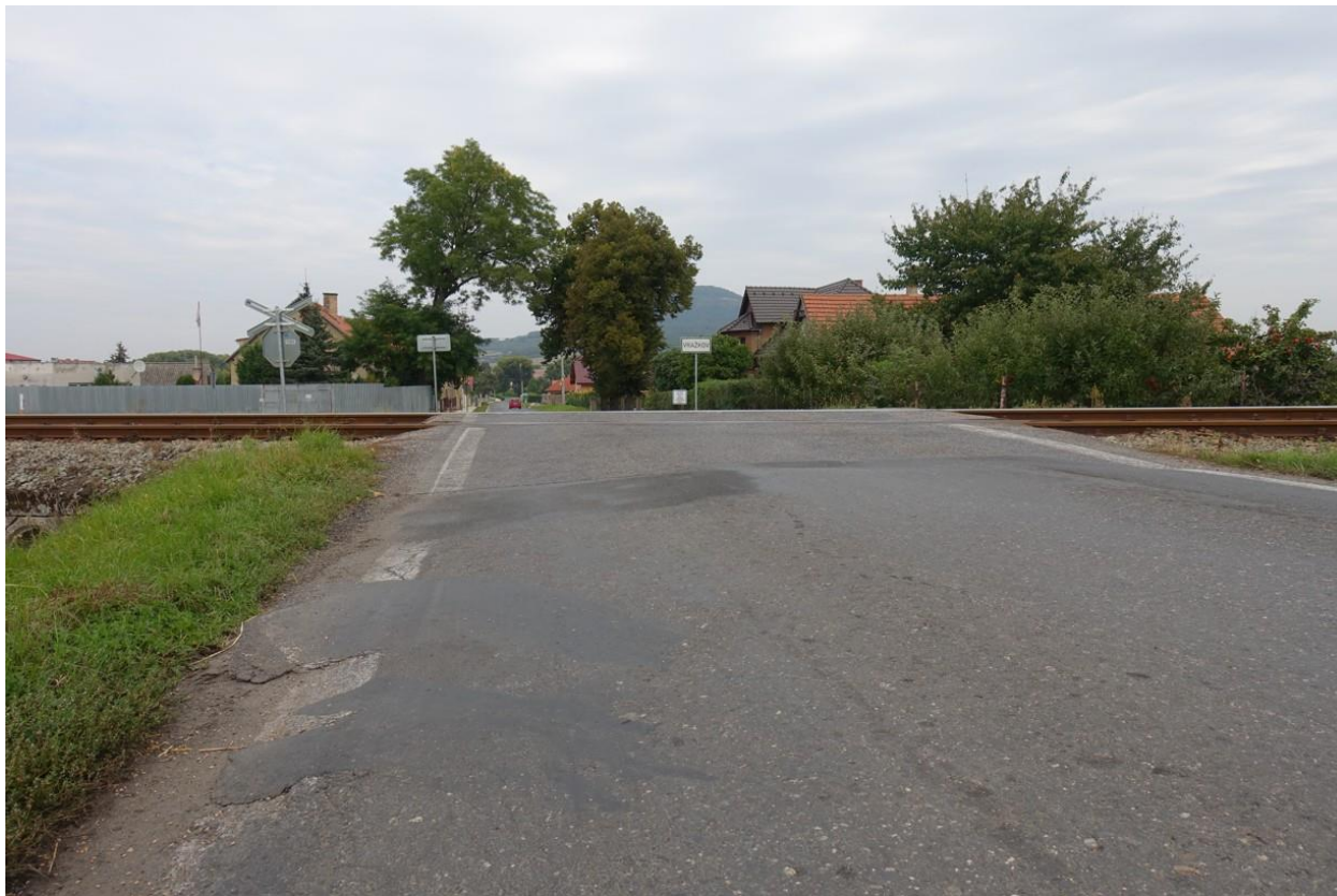
Foto 4 – Pohled na přejezd P2553 ve směru jízdy po komunikaci na Vražkov – za přejezdem je výrazný nenormový zlom v niveletě komunikace
