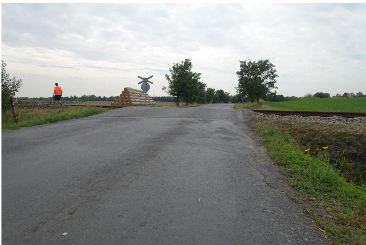
Foto 5 – Pohled na přejezd P2553 ve směru jízdy po komunikaci na Stražkov – před přejezdem je výrazný nenormový zlom v niveletě komunikace
